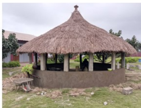
Aujourd'hui : l'apatam terminé
